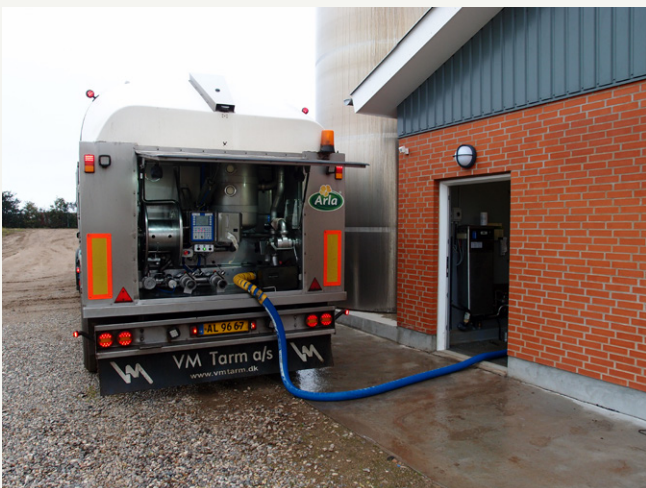
Silotank placeret på siden af bygningen med direkte adgang for tankbilen til mælkerummet
