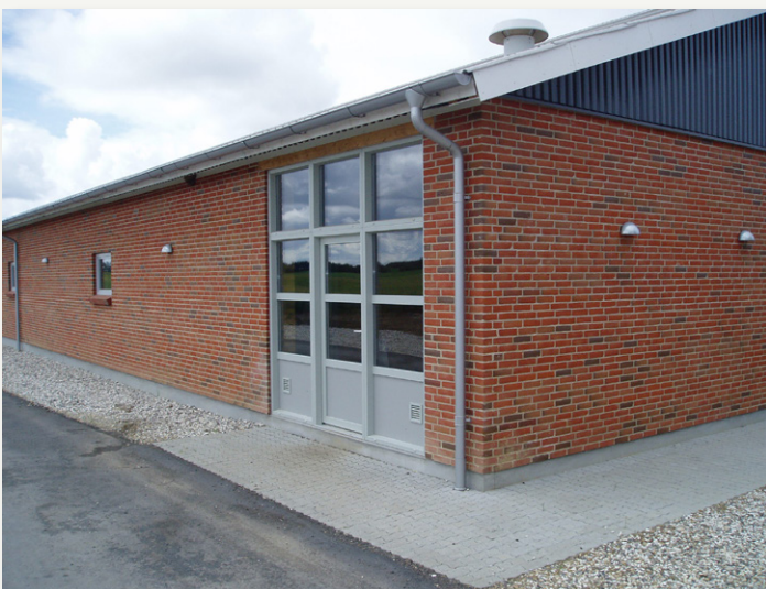
Adgang til mælkerum med indadgående dør og direkte adgang til afhentningsstudsens
