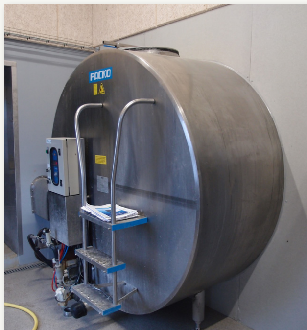
Liggende tank, hvor kun den forreste del af tanken er placeret i mælkerummet med tankstuds og mandeluge
