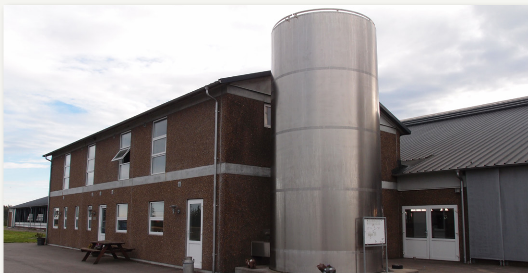
Servicebygning indeholdende mælkerum, teknikrum og personalefaciliteter.
